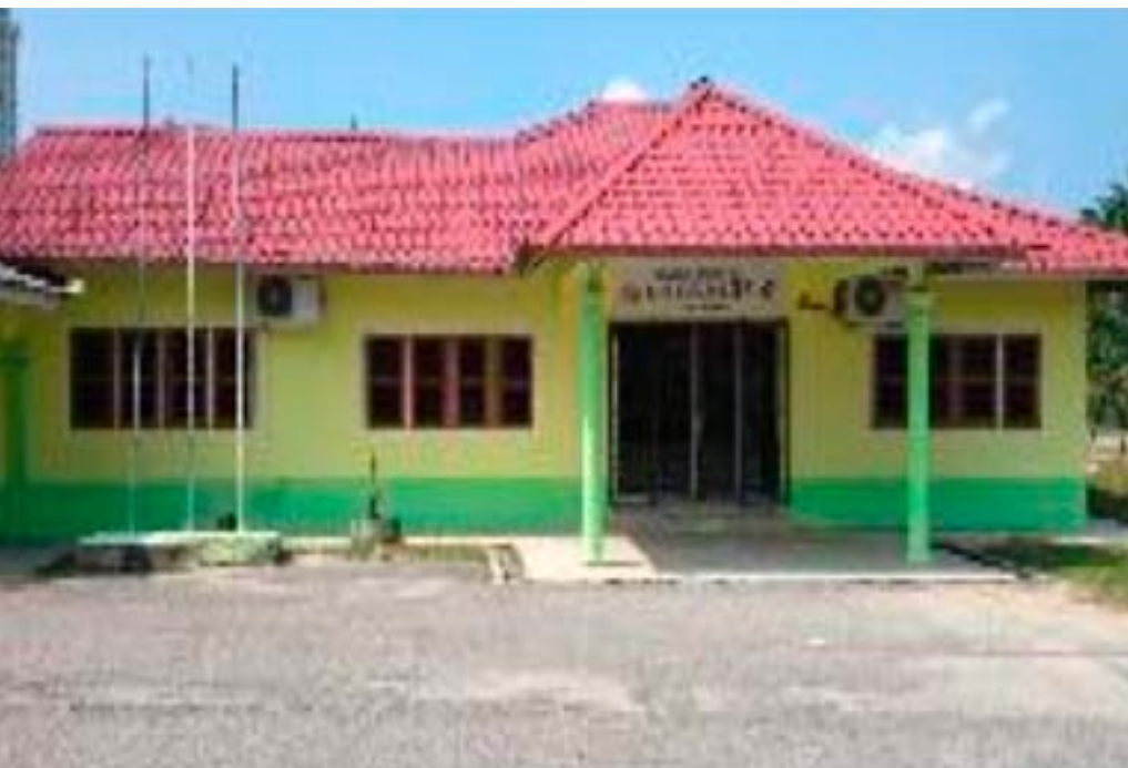
Baikpulih Bangunan FELCRA Keruak, Terengganu.
