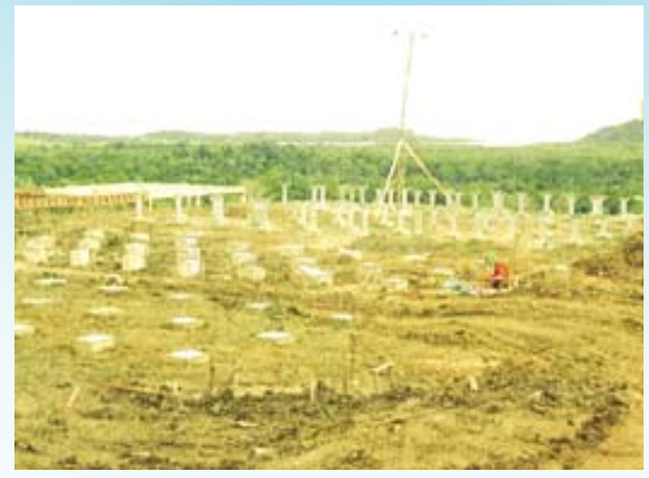
Gambar Projek Pembinaan Jana kuasa Elektrik.
