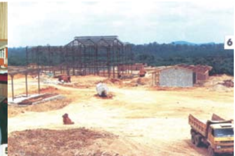
Kilang sawit FELCRA dalam pembinaan di FELCRA Bukit Kepong.
