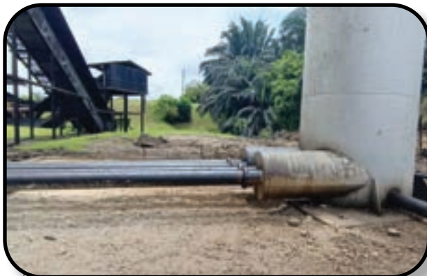
Steriliser Blowdown Chamber dalam pembinaan.
