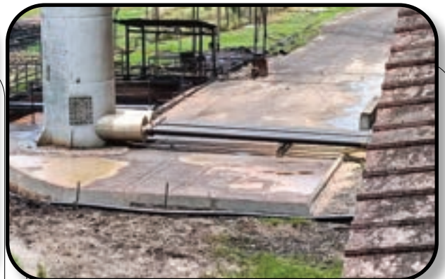
Steriliser Blowdown Chamber siap pembinaan sepenuhnya.
