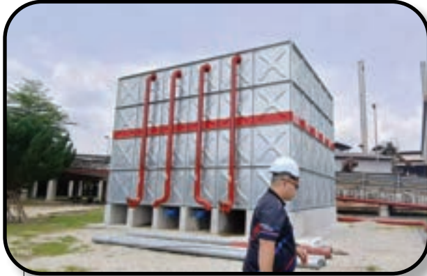
Tangki hydrant siap dibina dan dibuat pemeriksaan kebocoran.
