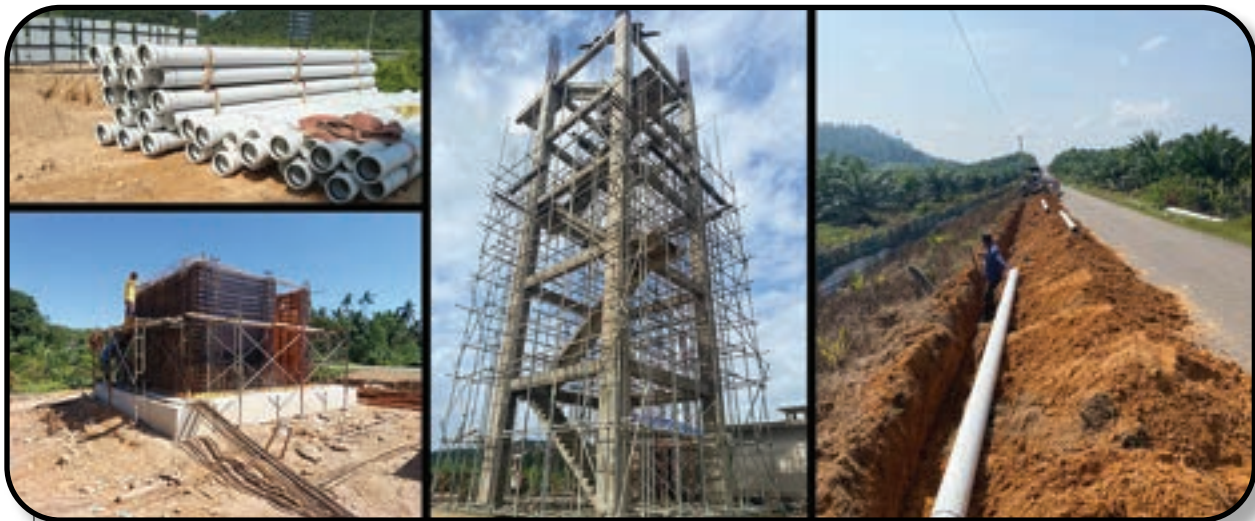
Contoh Kerja-kerja Pembinaan Rumah Pam.
