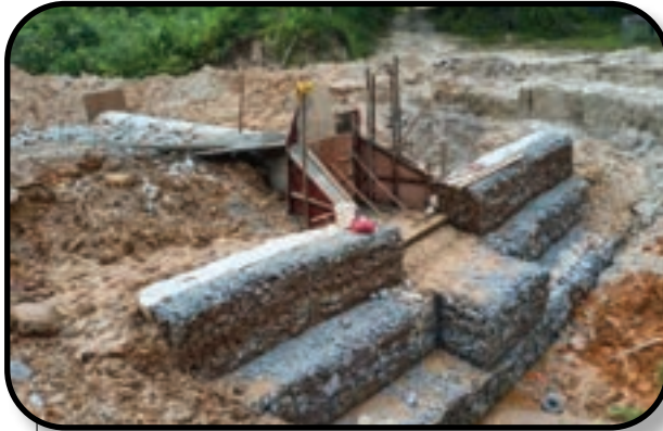
Pemasangan konkrit mekanisma tambak batu bertangga bagi saluran perparitan.
