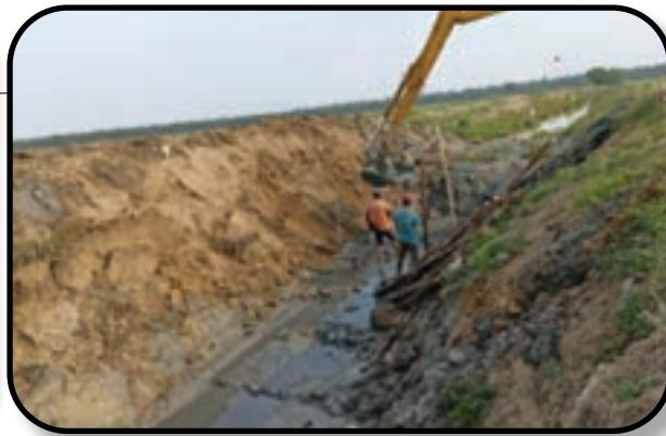
Kerja-kerja mengorek untuk persiapan pemasangan U-Drain System.
