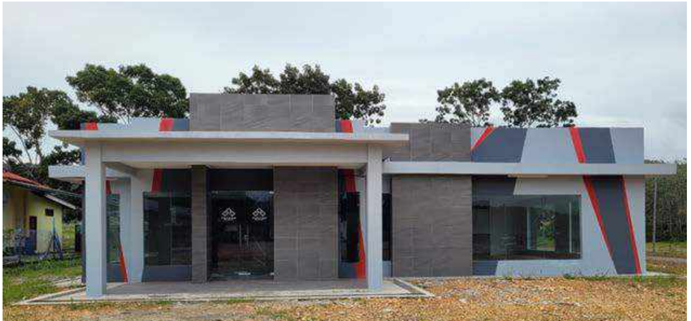
Bangunan Pusat Digital Desa di FELCRA Bukit Tampoi, Kedah.
